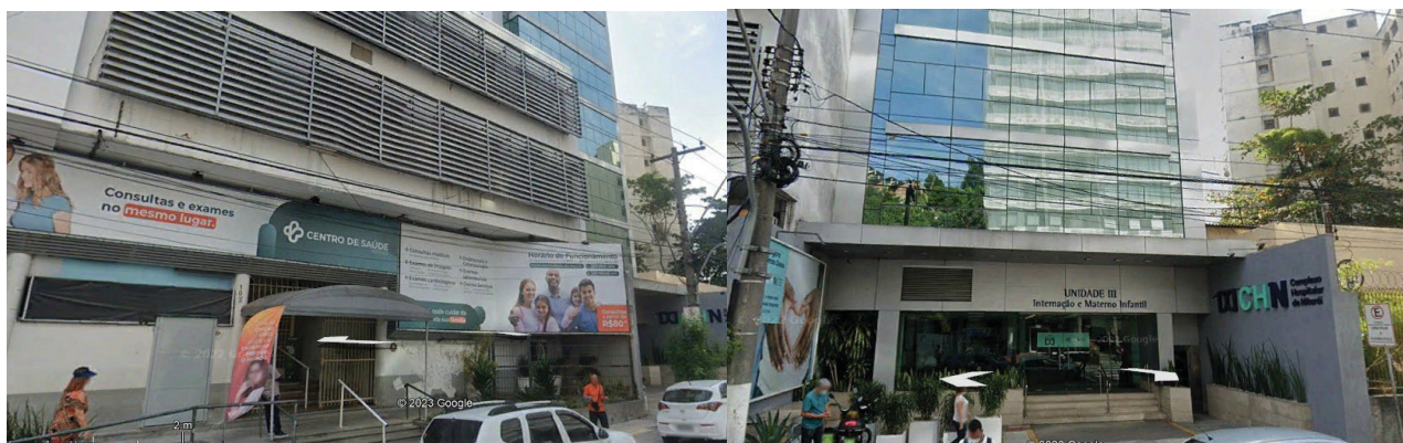
Figura 81: Centro de Saúde Niterói (municipal) e Centro Hospitalar de Niterói (particular) – foto: Google Earth
